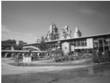
双龍セメント東海工場。340万坪の敷地で、年間1,150万トンの生産規模を有しています。双龍セメントは日本の太平洋セメントとの資本関係があります。
